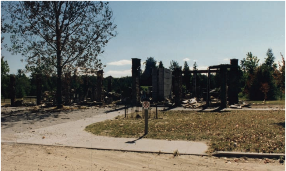
Pièce P-24 – photo 21 : Le magasin incendié du parc provincial.
